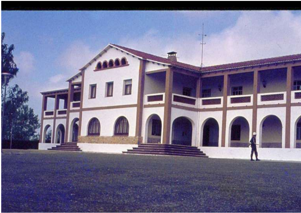
Edificio de Mando
